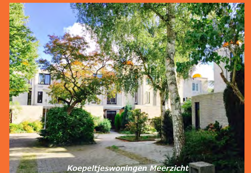
Houtbouw Vuurdoornpark Seghwaert (foto Copyright D.Valentijn)
